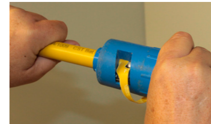
Bild 10: Abmanteln des Kunststoffmantels auf Einschubtiefe
