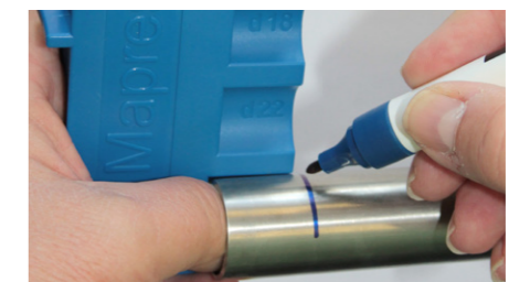
Bild 14: Markieren der Einschubtiefe mit Einschubtiefenlehre
