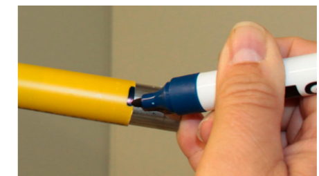
Bild 13: Markierung der Einstecktiefe bei Verwendung von Mapress Abmantelgerät
