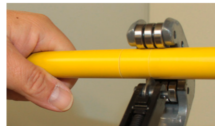
Bild 7: Anritzen des Kunststoffmantels
