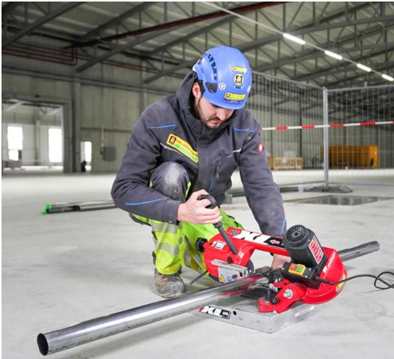
↑ Installateur Flurin Lütschg zersägt Mapress Rohre mit einer Bandsäge.
