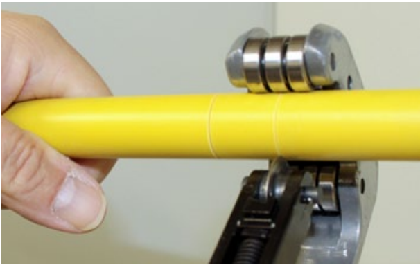
Bild 7: Anritzen des Kunststoffmantels
