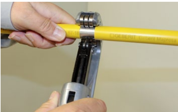
Bild 9: Trennen von Rohr bei entferntem Kunststoffmantel
