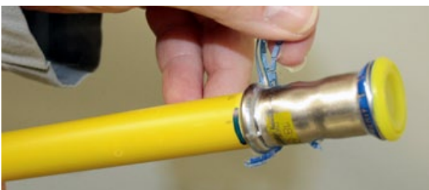
Bild 20: Pressindikator lösen
