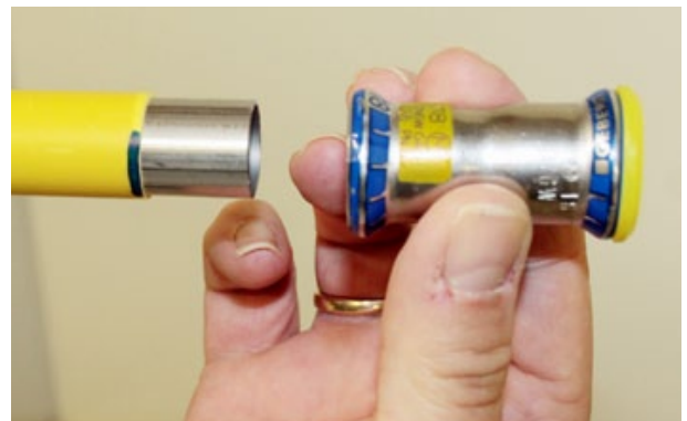
Bild 16: Ineinanderschieben von Systemrohr und Pressfitting
